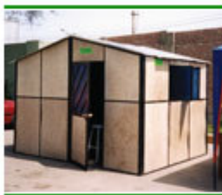
Casa de Tectán
